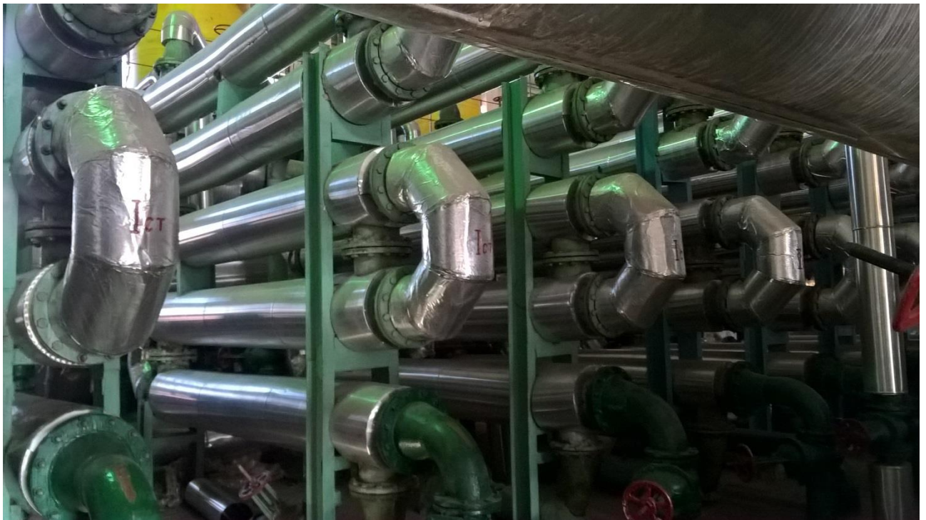
Рис.2. Аппараты, вместо одной секции которых был установлен два аппарата ТТАИ
