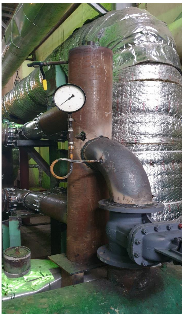
Рисунок 1.3 Схема подключения теплообменного аппарата ТТАИ: а. – схема измерений; б. – теплообменный аппарат.
