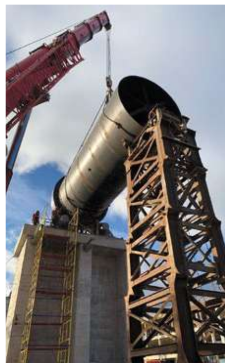
Монтаж элементов печи обжига
