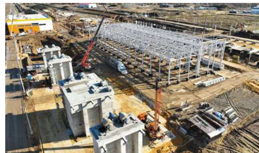
Вид на строительную площадку ООО «ЕВРАЗ Узловая»
